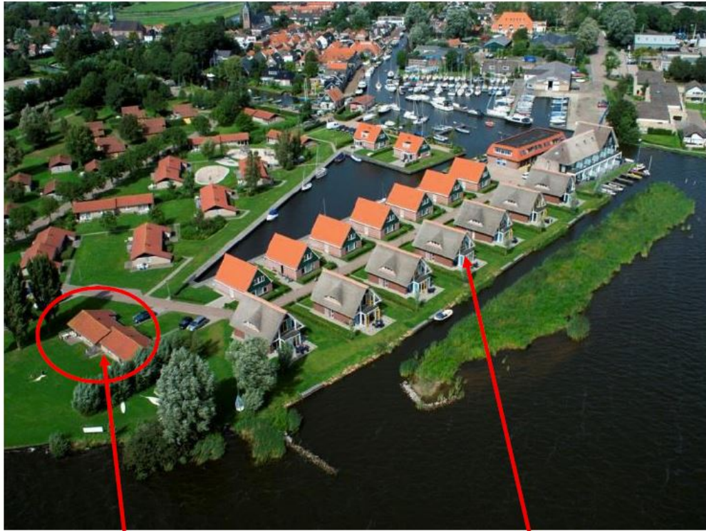
2 van de 4 te slopen recreatiewoningen
