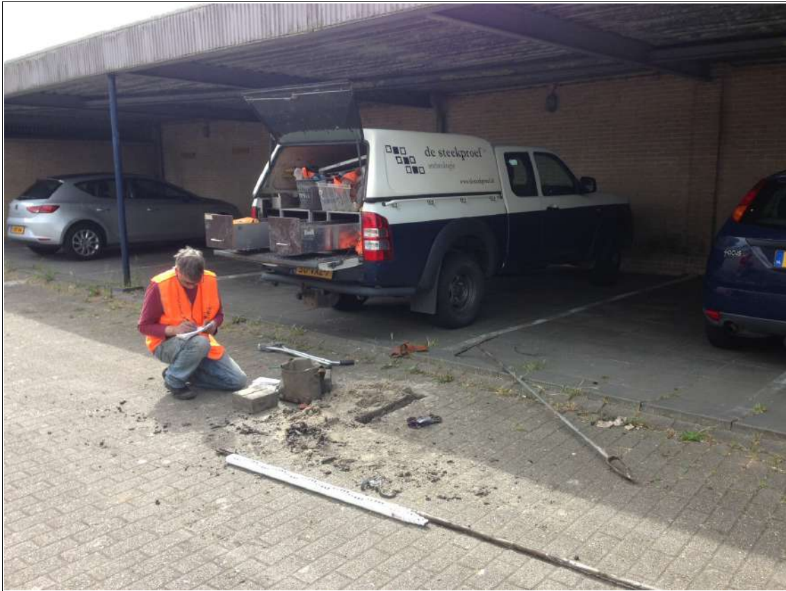
Figuur 7: Sneek, IJlsterkade 47: Het beschrijven van de boring 3.
