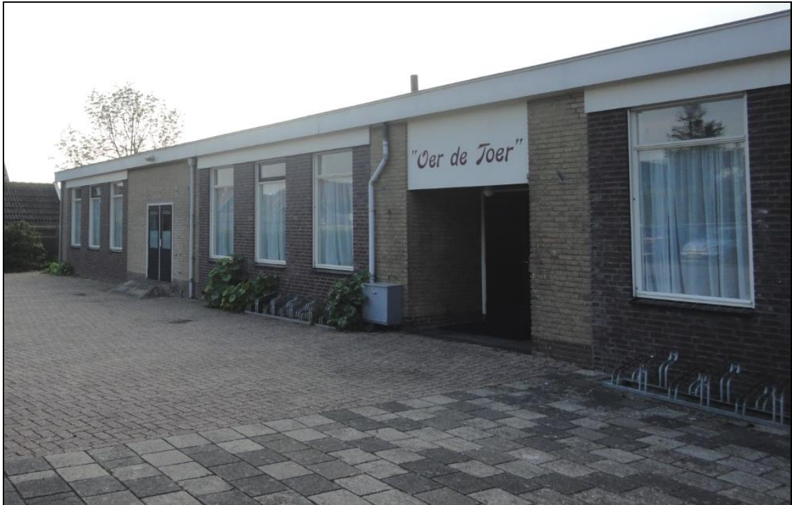
Fig. 2: aanzicht bestaande situatie voorgevel. Bron: Zeldenrust VROM-advies & Projectmanagement
