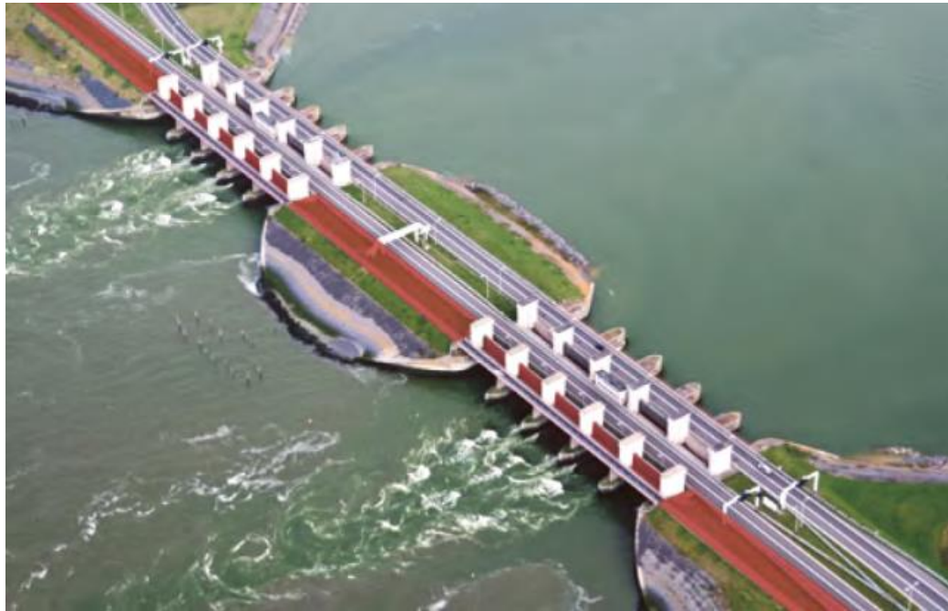
Figuur 2.4: Luchtfoto's met in rood de waterkering van spuicomplex Kornwerderzand links: Waddenzee, rechts: IJsselmeer) (Bron: Inpassingsplan Afsluitdijk)
