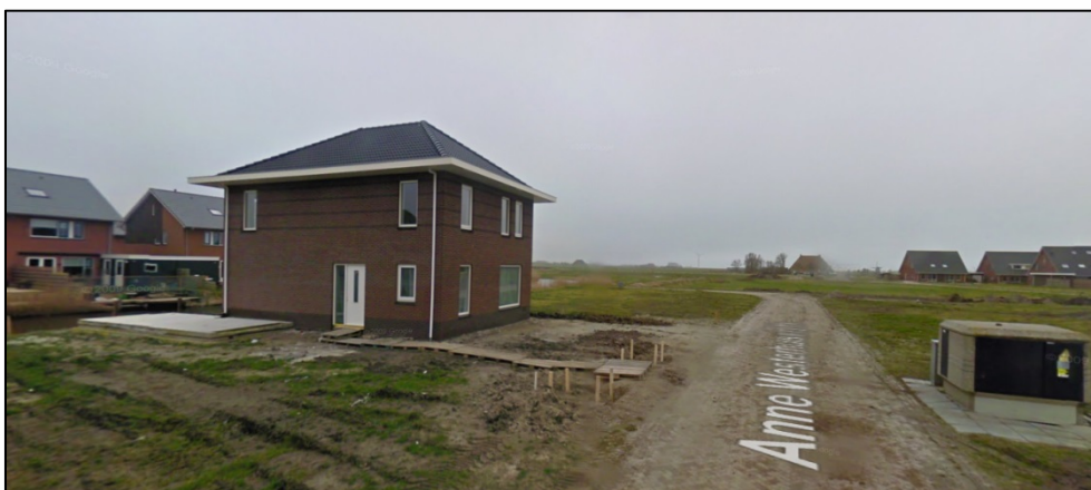
Figuur 4. Aanzicht op de bestaande woning en daarachter het projectgebied
