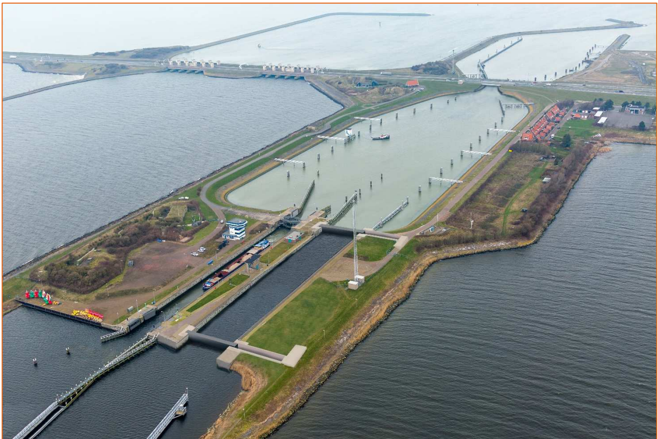
Figuur 1 Variant Oostelijke schutsluis
