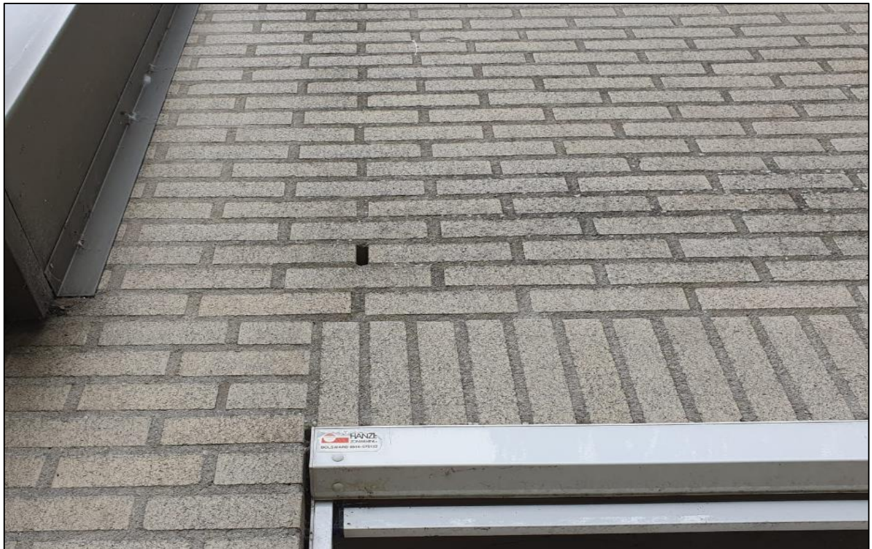
Figuur 2.4.: In een deel van de bebouwing zijn stootvoegen aanwezig.
