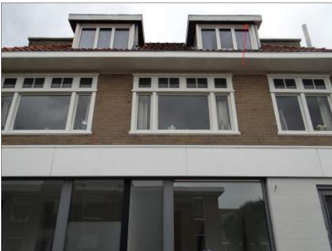
Afbeelding 1. Nestlocatie van gierzwaluw in de dakkapel aan de noordzijde van het gebouw waar tijdens de drie inventarisaties invliegende gierzwaluwen zijn waargenomen (rode pijl).
