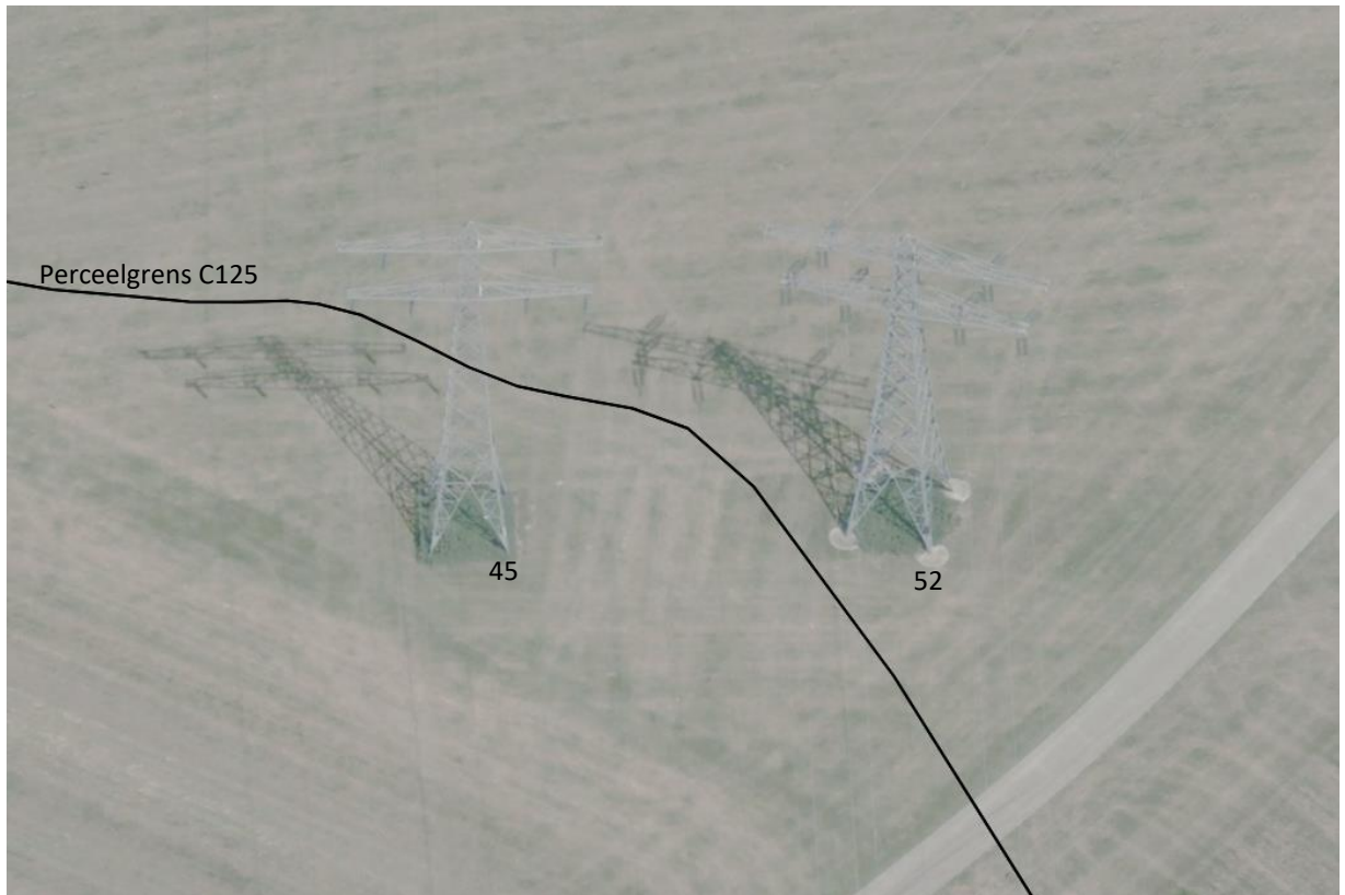
Figuur 2-1: Huidige situatie van mast 45 (links). Rechts staat mast 52 en de zwarte lijn is de perceelgrens van perceel C125.
