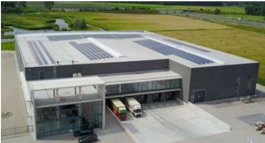
Zonnepanelen op daken
