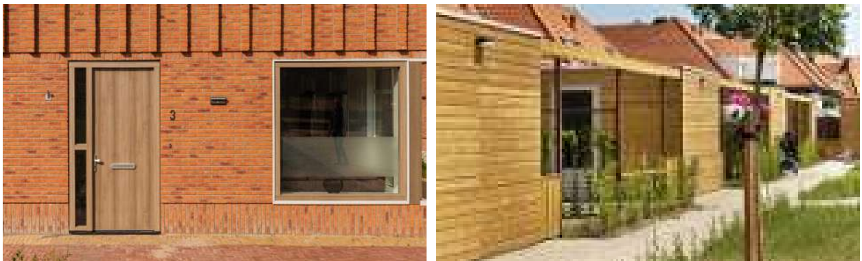
Baksteen met houten detaillering (sociale woningbouw, Hallum). Rechts voorbeeld van een eenduidig beeld richting de binnentuin, met een afwisseling tussen open delen en een gesloten berging (Tivoli, Eindhoven).
