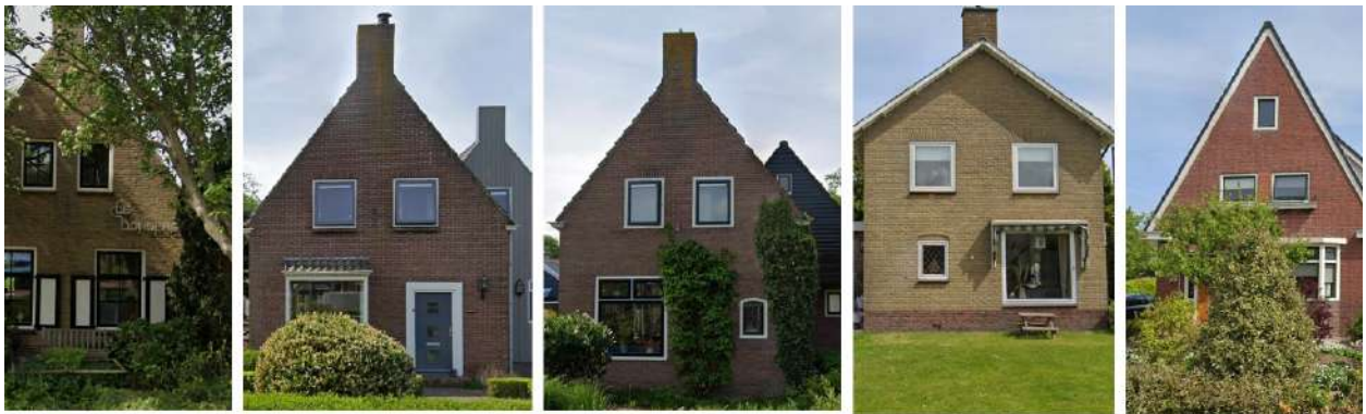
Warme kleur metselwerk
