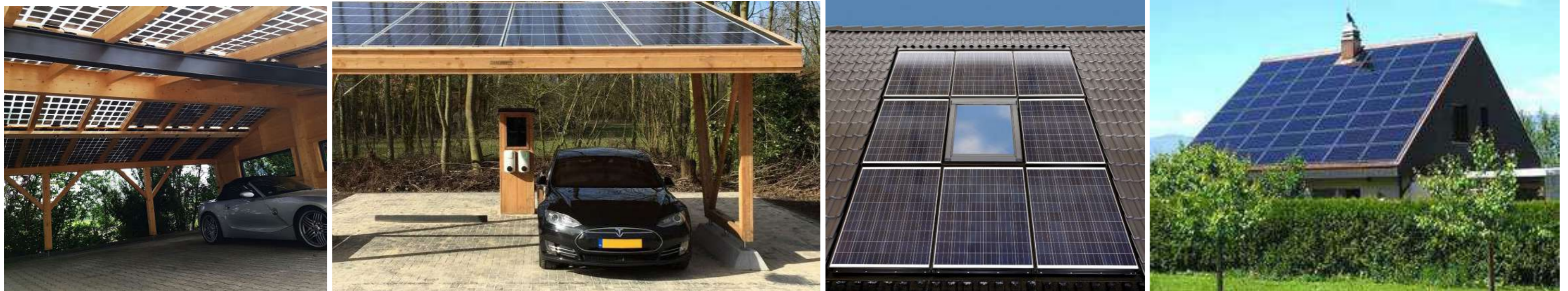
Zonnepanelen, luchtwarmtepompen en zonneboilers zijn zorgvuldig geïntegreerd in de architectuur van de woningen en carports
