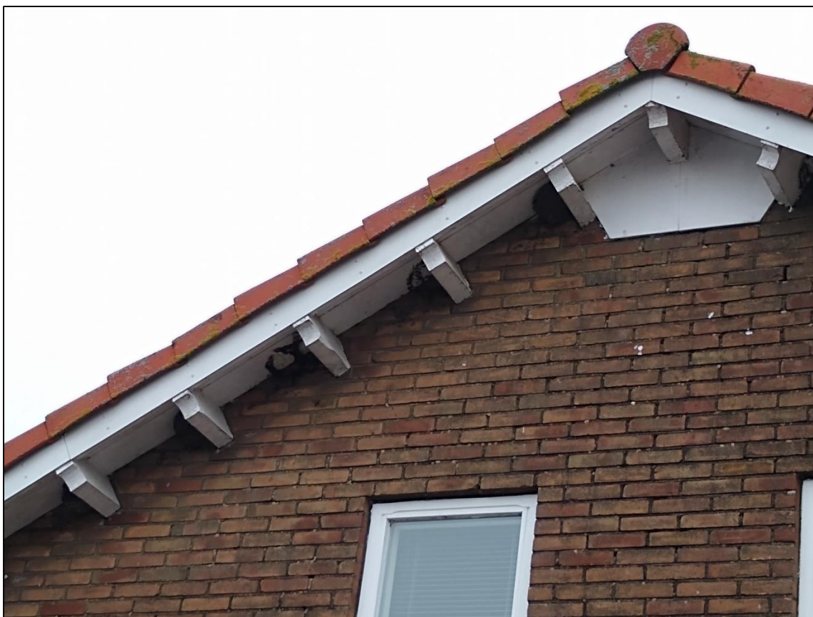
Figuur 2.2. Huiszwaluwnesten onder de dakrand van de woning/werkschuur binnen het plangebied.
