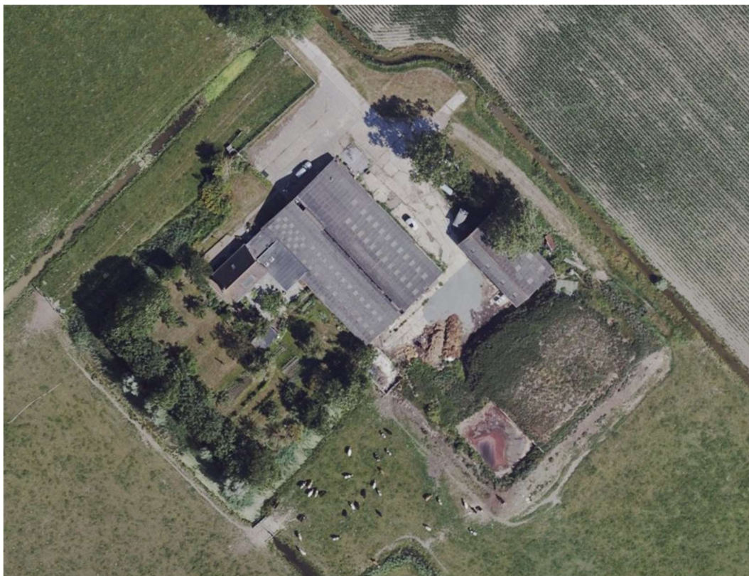
• Figuur 2: Luchtfoto locatie Blankendalwei 3 (bron foto: Street Smart bij Cyclomedia)
