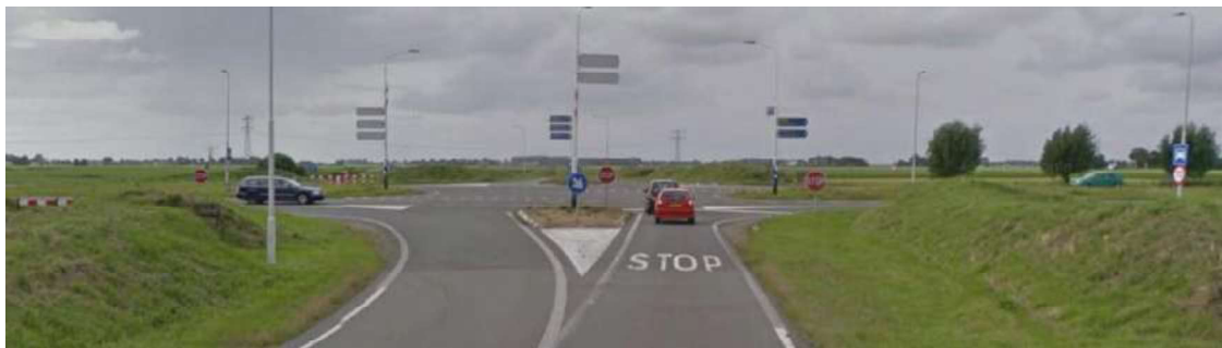
Figuur 2.1 Huidige kruising N359 - Wibrandaweg (bron: Google Streetview)
