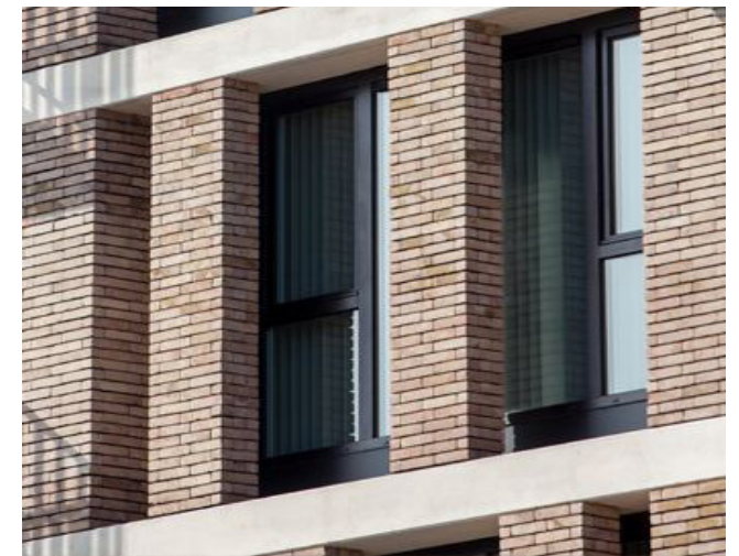
ramen liggen verdiept in het gevelvlak
