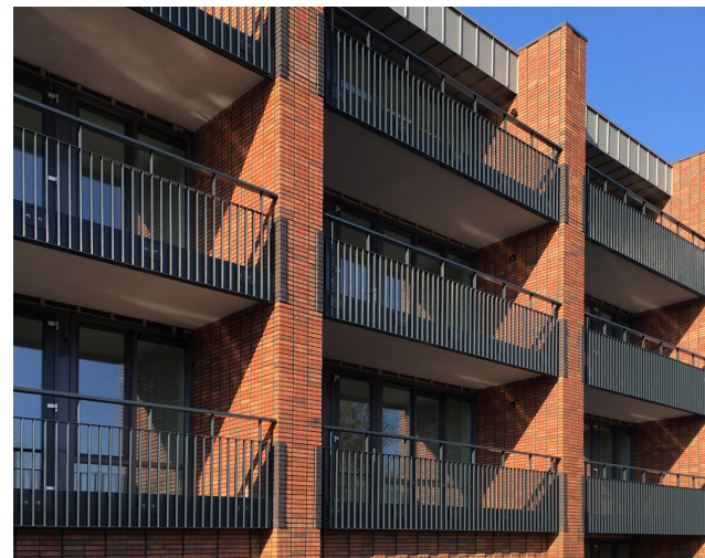
transparantie van de gevel / balkons en galerij
