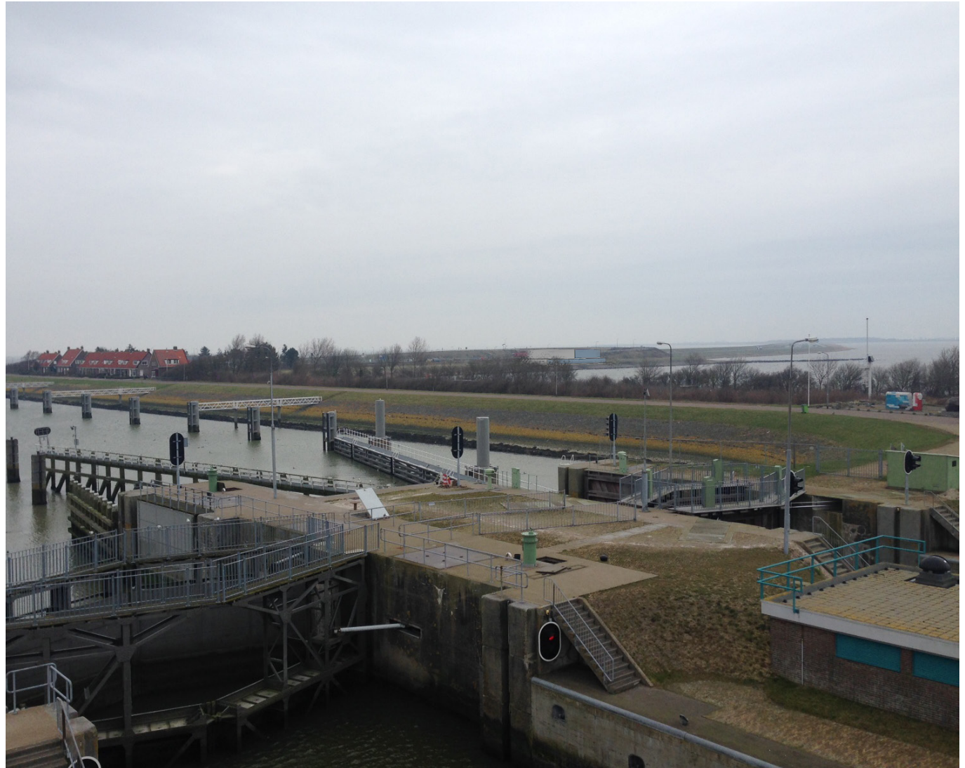
Foto vanuit verkeerstoren met montage gebouw. Vanuit de nautische functie van Kornwerderzand als verbinding voor beroeps- en recreatievaart tussen Waddenzee en IJsselmeer is het noodzakelijk dat vanuit de bedieningstoren van de sluis zicht is op de vaarroute op de Waddenzee.
