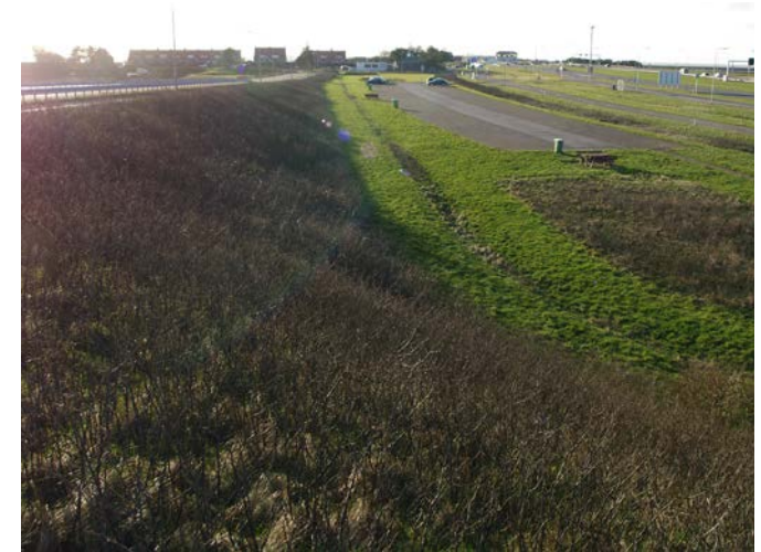
Hondsroos op de taluds
