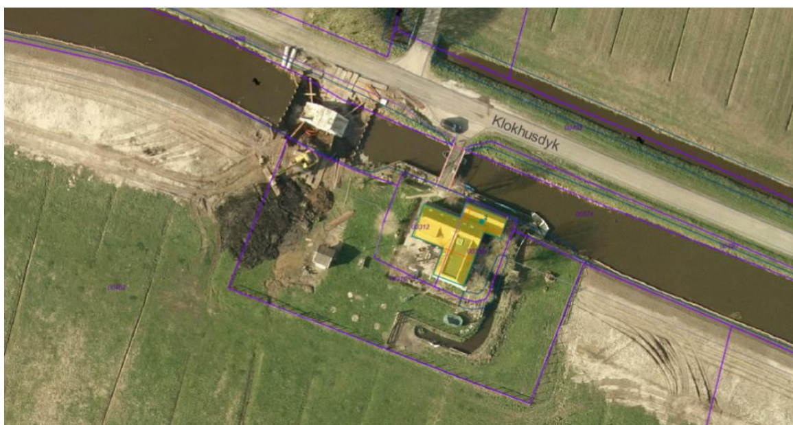
figuur 1: Situatietekening waarop oude (bij woning) en nieuwe brug (in aanbouw) zichtbaar.
