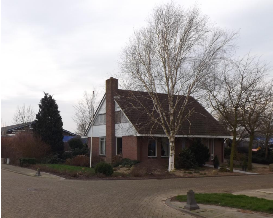
It Eilân 2. Aan de schoorsteen worden twee vleermuiskasten opgehangen
