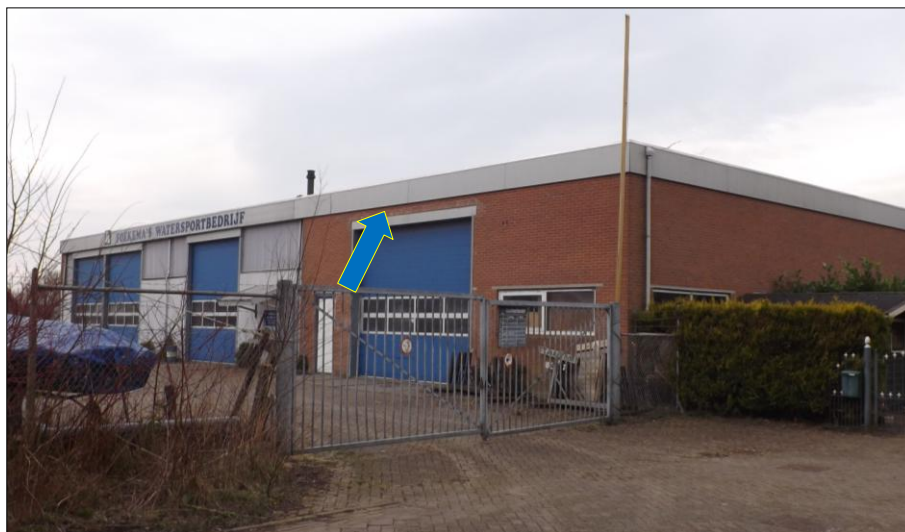
Figuur 5. Oostgevel loods met verblijfplaats ruige dwergvleermuis
