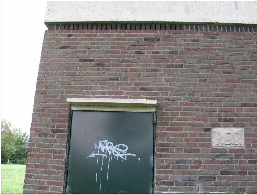
Figuur 8. Het te slopen nutsgebouwtje
