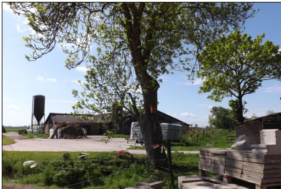
Figuur 3. Zicht op een bedrijfsgebouw dat gedeeltelijk wordt vergroot
