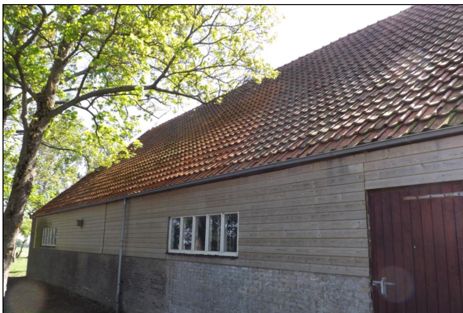
Figuur 4. Zicht op een bedrijfsgebouw dat gedeeltelijk wordt gesloopt
