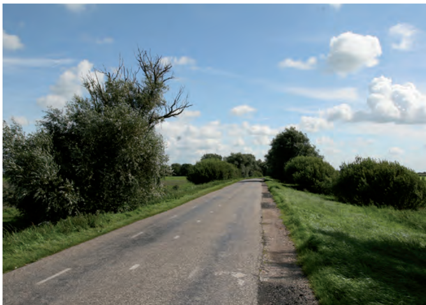
De hemdijken zijn op een aantal plaatsen dichtgegroeid
