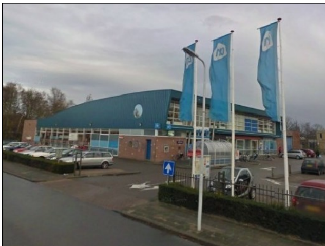
Figuur 7. Opbouw aan voorzijde van de supermarkt (bron: Google Streetview, 2013)
