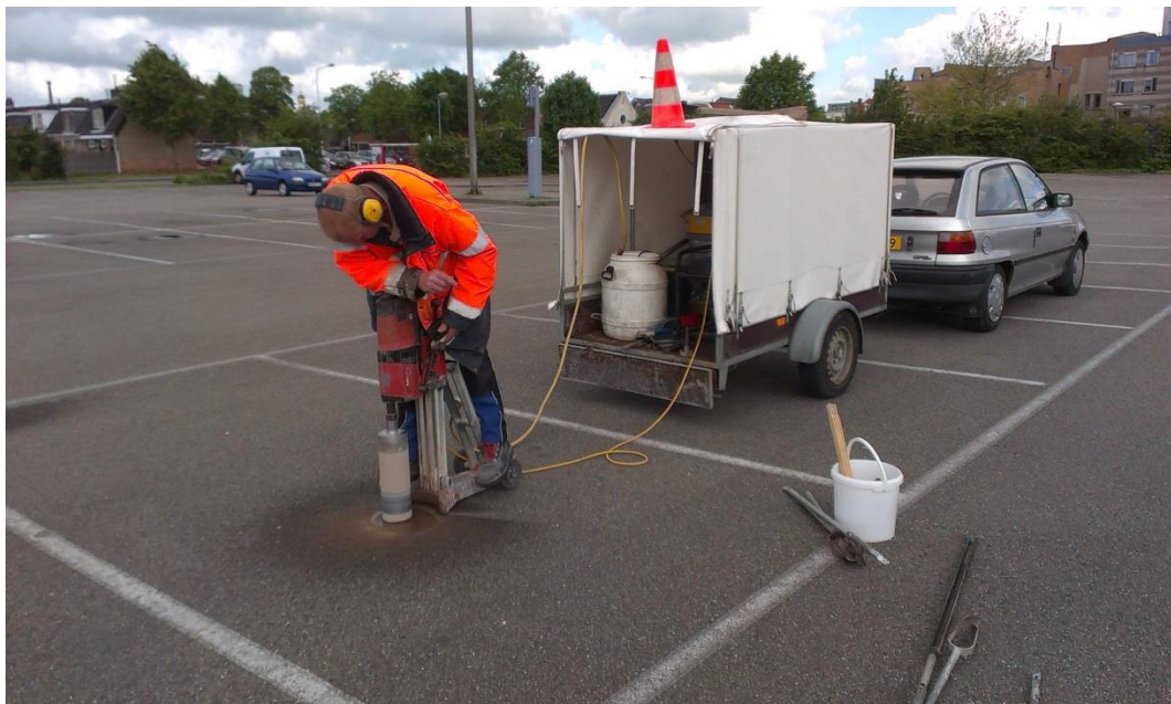
Afbeelding 7. Een foto van het veldwerk, het voorboren van de gaten met een betonboor.
