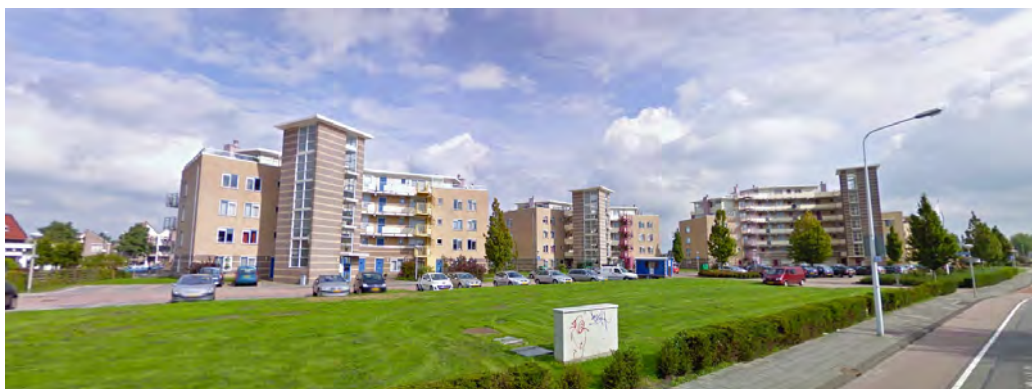
Bebouwing aan de zuidzijde van het projectgebied
