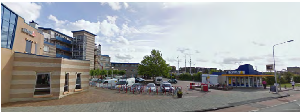
Bebouwing aan de noordzijde van het projectgebied
