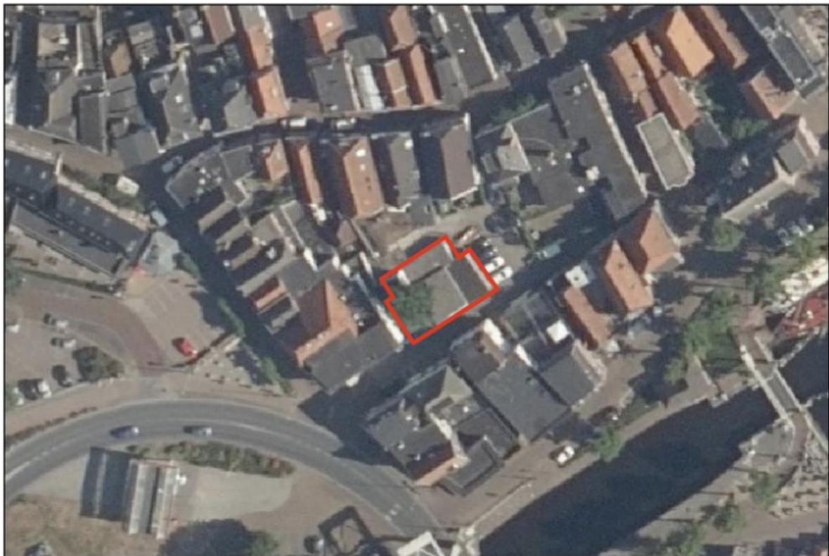
Afbeelding 2.1 Luchtfoto huidige situatie projectgebied (Bron: PDOK)
