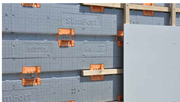
Afwerking met vezelcementplaten
