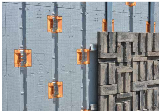
fischer draagsysteem met steenstripafwerking
