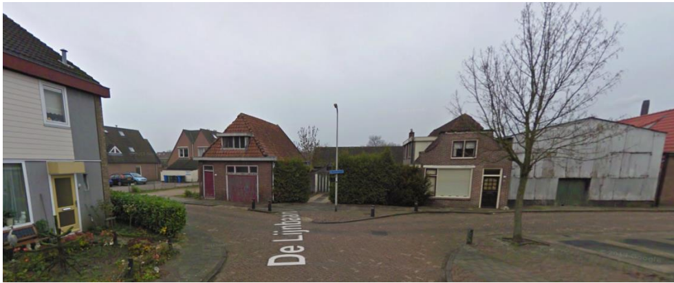
Figuur 3. Situatie voor de sloop van de opstallen (referentiesituatie)
