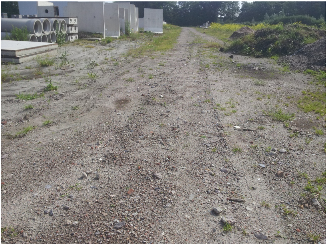
Puinbaan op oostelijk terreindeel
