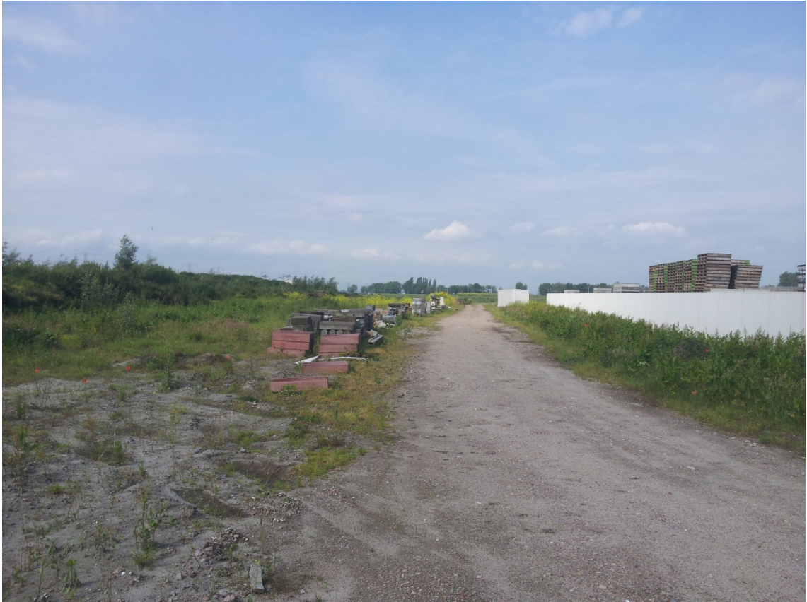
Overzicht oostgrens terrein in westelijke richting
