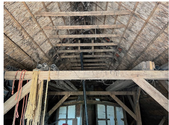
Figuur 7. Interieur gebouw 2.
