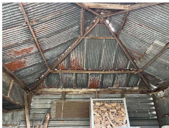
Figuur 7. Interieur gebouw 5.
