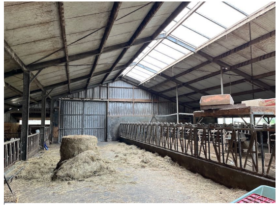
Figuur 5. Interieur gebouw 1.
