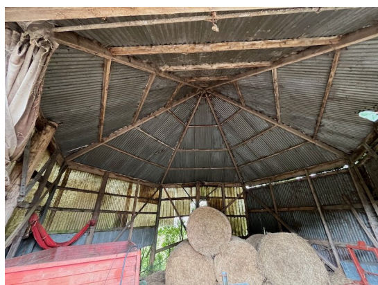
Figuur 9. Interieur gebouw 6.
