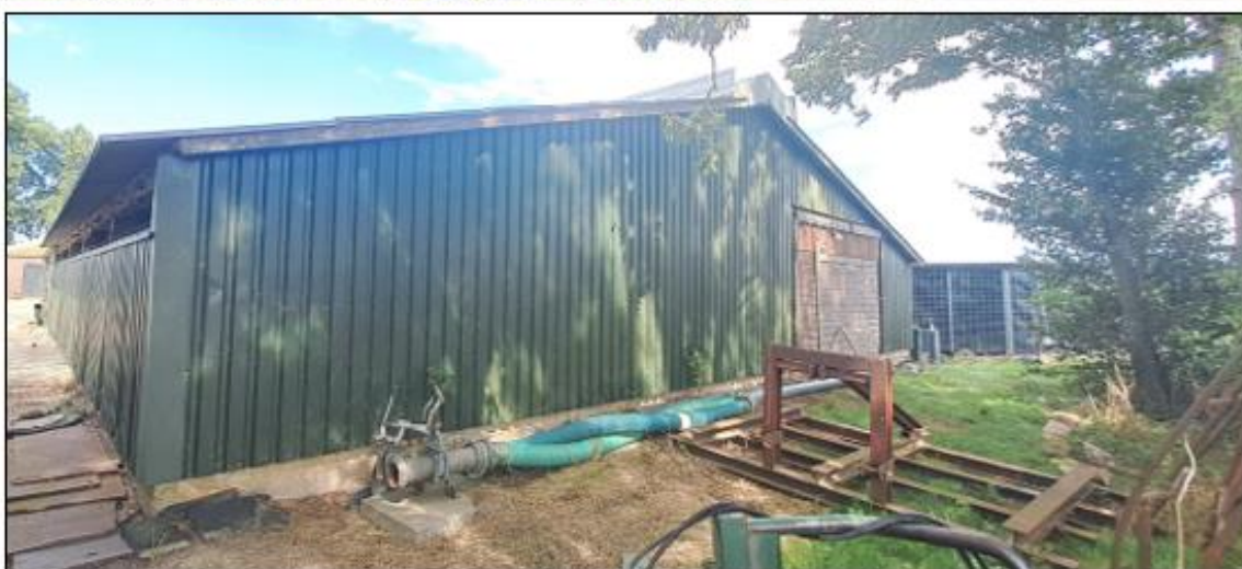
Figuur 4, opstal D vanaf beide zijdes gezien (foto's: Laneco, 2023).
