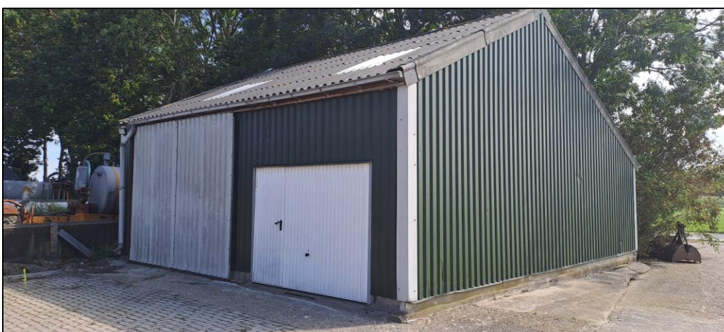
Afbeelding 4. Boven: opstal H (links), opstal E (midden) en opstal A (rechts) gezien vanaf het noorden; midden: opstal E gezien vanaf het zuidoosten met rechts opstal I; onder: opstal F gezien vanaf het westen; (foto's: Laneco, 2023).
