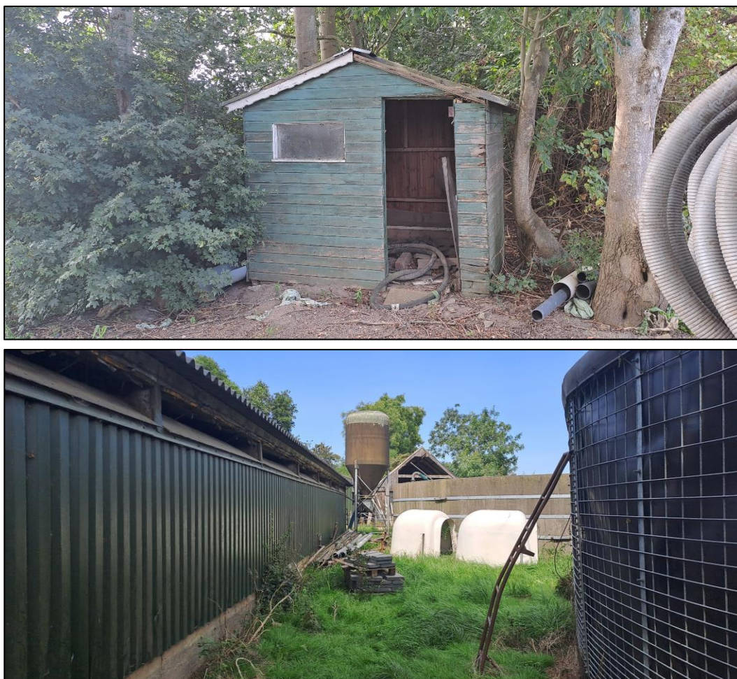
Afbeelding 5. Boven: opstal G gezien vanaf het noordoosten; onder: de achterkant van opstal E (links), opstal H (midden) opstal I (rechts); (foto's: Laneco, 2023).
