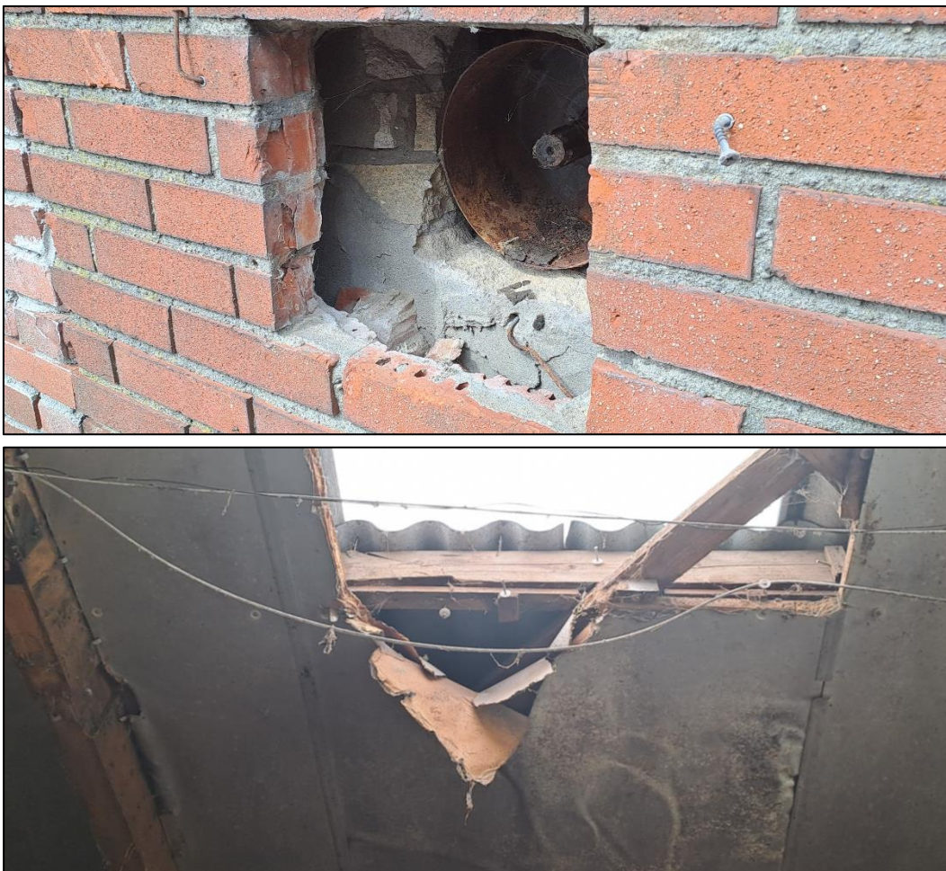
Afbeelding 7. Geschikte ruimtes in de bebouwing binnen het plangebied; boven: ruimte in de spouw van opstal A; onder: ruimte onder dakbeschot van opstal E; (foto's: Laneco, 2023).
