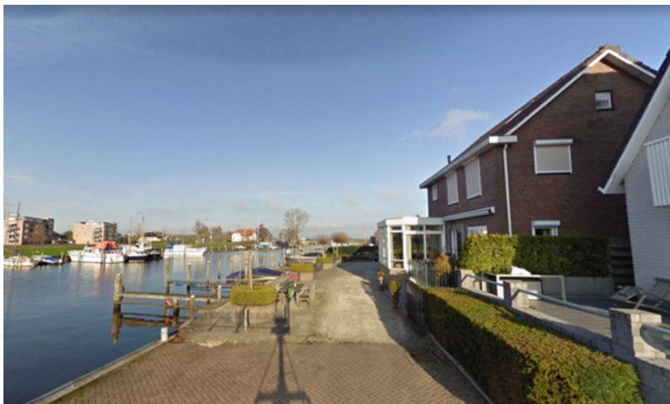
Voorzijde woningen Buitenhaven 2a/b-3, grenzend aan het water van de haven
