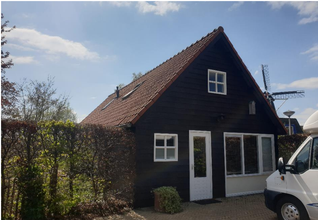
Figuur 1.4 De noordelijke kopgevel van het bijgebouw dat als woning wordt gebruikt.
