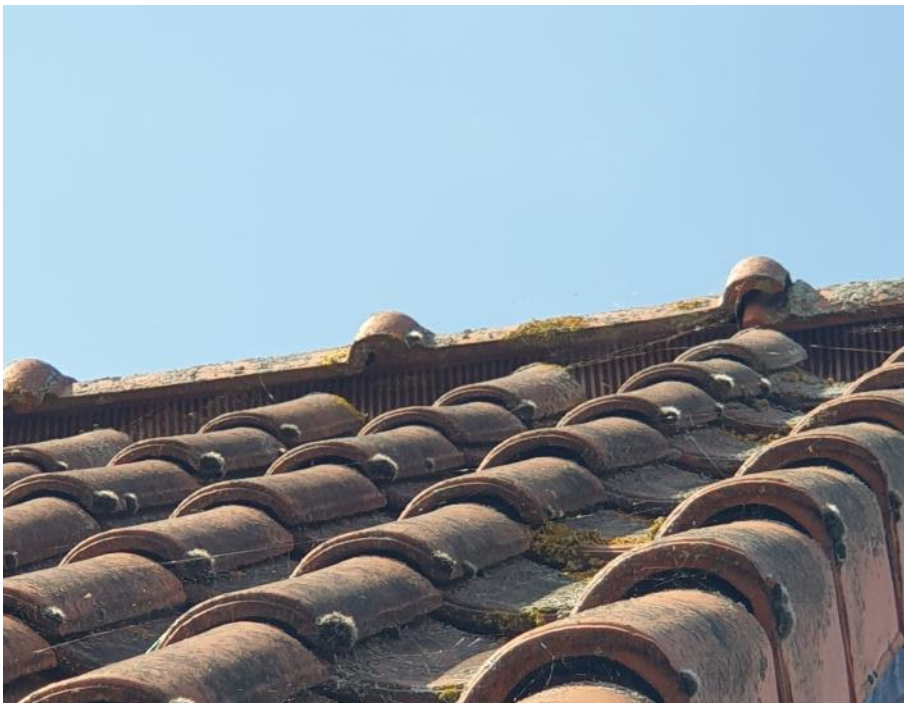
Figuur 4.3 De nokpannen zijn afgesloten.
