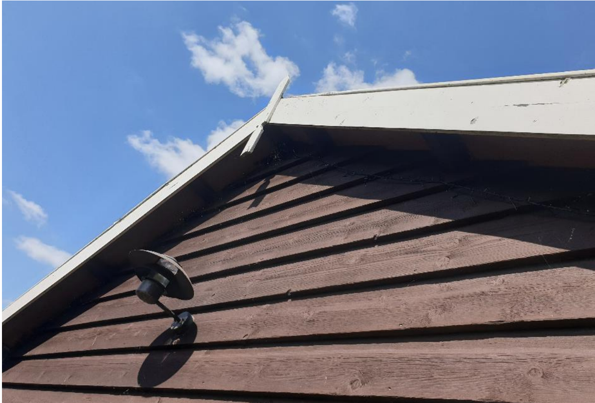
Figuur 4.4 De twee gebouwen hebben bij de kopgevels een overstek van hout.
