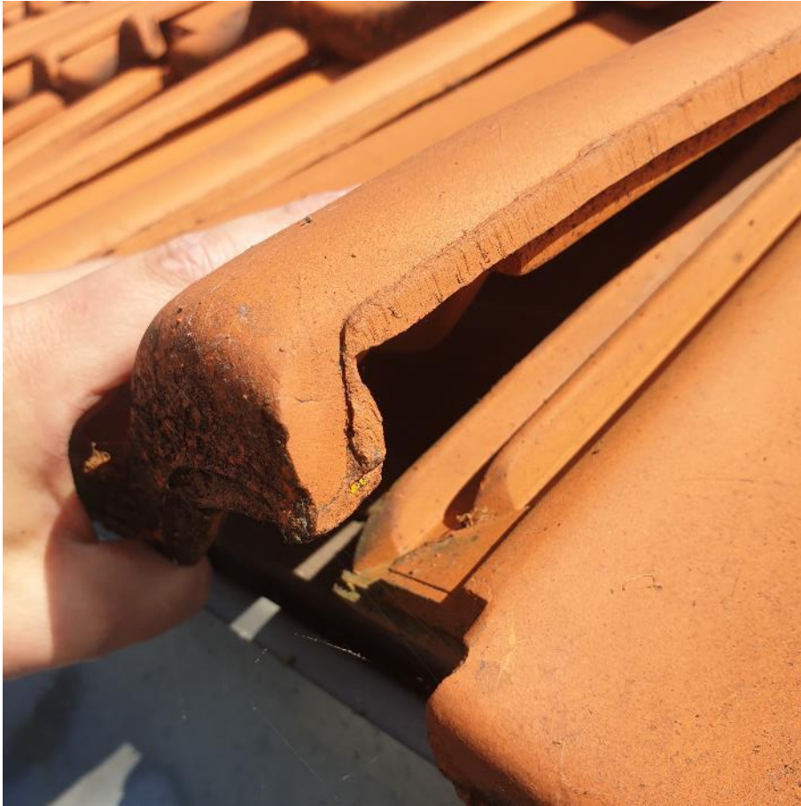
Figuur 4.1 Onder de eerste rij dakpannen zijn houten latten aanwezig.
