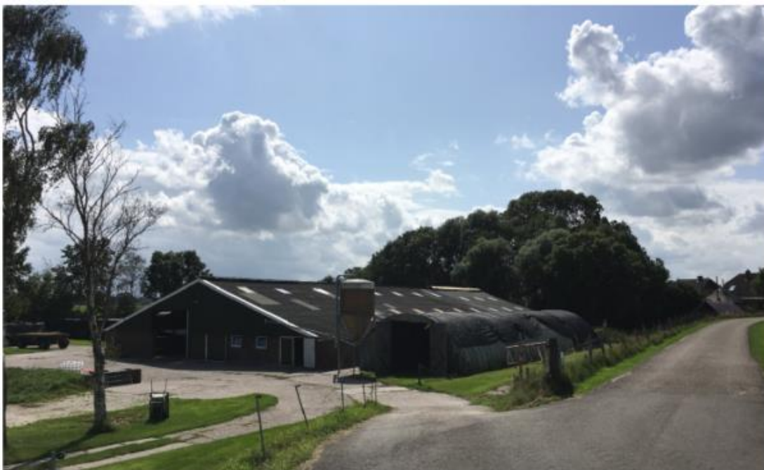
Figuur 5: Westelijke deel van het onderzoeksgebied met de romney loods en stal gezien vanuit het noordoosten (bron: Eelerwoude 2020).
