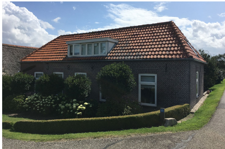
Afbeelding 7. Voorhuis dijkwoning Pelkahoeve met erfbeplanting en haag om voortuin.
