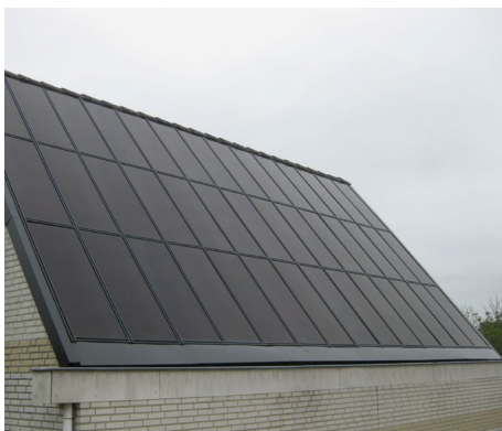
Afbeelding 42. Referenties all-in dakoplossing en zonnepanelen geïntegreerd in het dak.
