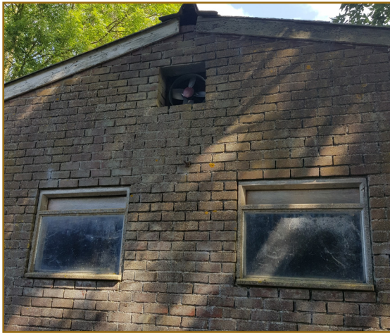
Afb. 2.7: Overzichtsfoto van de boeiplanken waarachter ruimte is voor vleermuizen aan de westkant van de stal.
