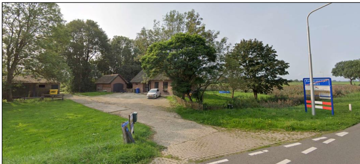
Zicht op de entree van het perceel vanaf de Kamperzeedijk.
