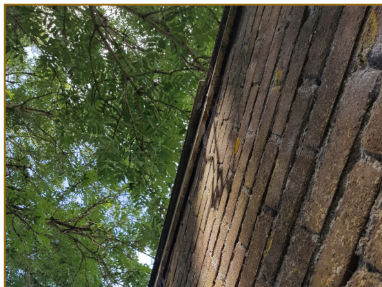
Afb. 2.5: Geschikte ruimte voor vleermuizen tussen de boeiplanken en de muur aan de westkant van de stal.
