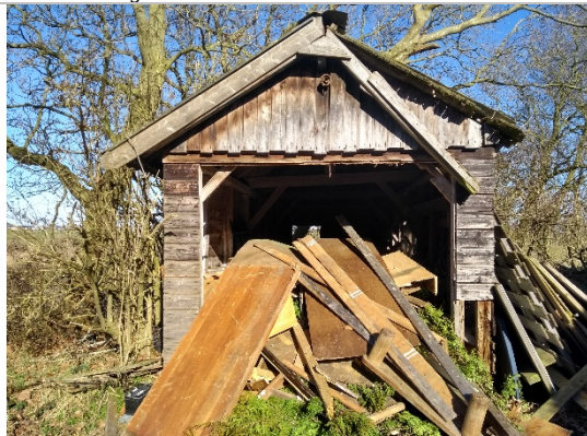
Foto 5: Een van de schuren bij Cellemuiden 41. Deze schuur wordt nu als dumpplaats gebruikt. De schuur wordt gesloopt, de omliggende bomen worden gekapt en er worden woningen gerealiseerd.
