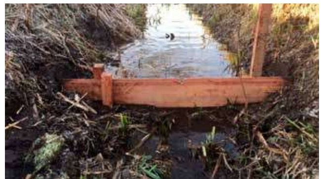
Voorbeeld stuw in sloot
