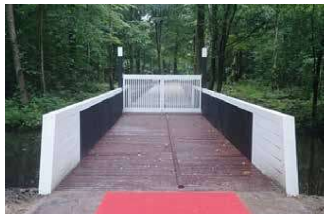
Voorbeeld van houten brug met markante witte wangen
