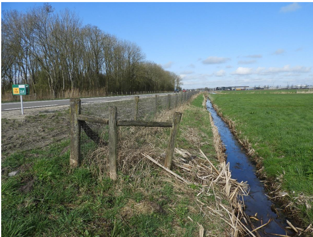
Figuur B2.3 Rastereind aan de oostzijde van de weg met omkeervoorziening (haaks deel), iets ten noorden van de entree tot het RWZI terrein, bij hectometerpaal 2.4.
