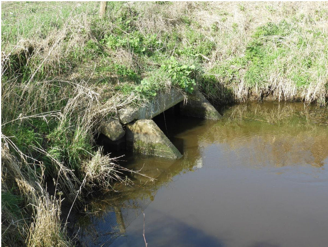
Figuur B2.9. De duikeropening met beperkte geschiktheid voor medegebruik van otter, aan de oostzijde van N759 (bij de Roebollige beek).
