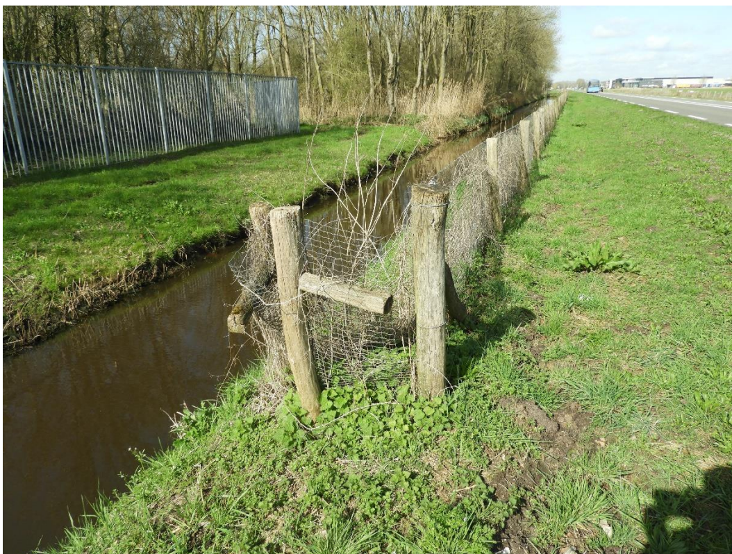
Figuur B2.4 Rastereind aan de westzijde van de weg met omkeervoorziening (haaks deel), iets ten noorden van de entree tot het RWZI terrein.
