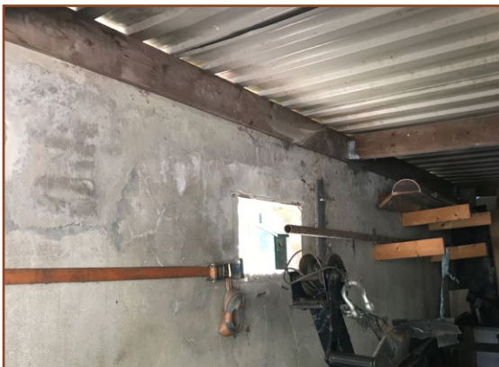
Afb. 2.2: De binnenkant van de schuur, half afgedekt met metalen dakplaten.
