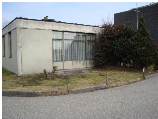
Figuur 3: Te slopen woningen naast het gemaal.
