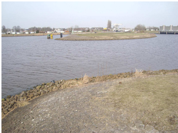
Foto 1: Aanzicht van het plangebied vanuit het zuiden, met in het centrum de keersluis en rechts het gemaal.
