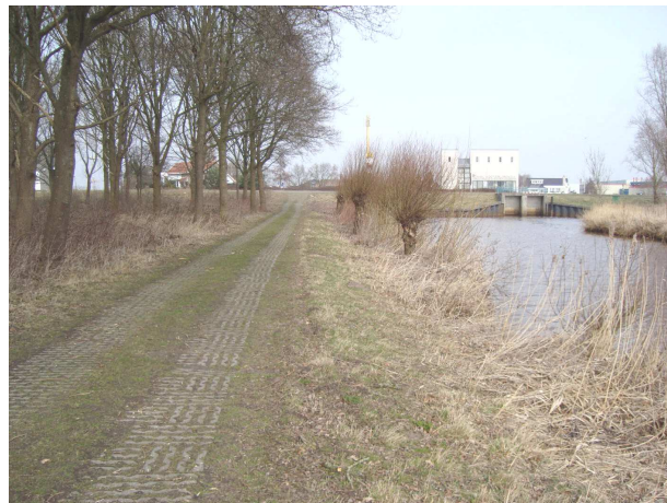
Foto 4: Zuidoosten van plangebied met uitlaat tweede gemaal (rechts) en eikenbos (links).
