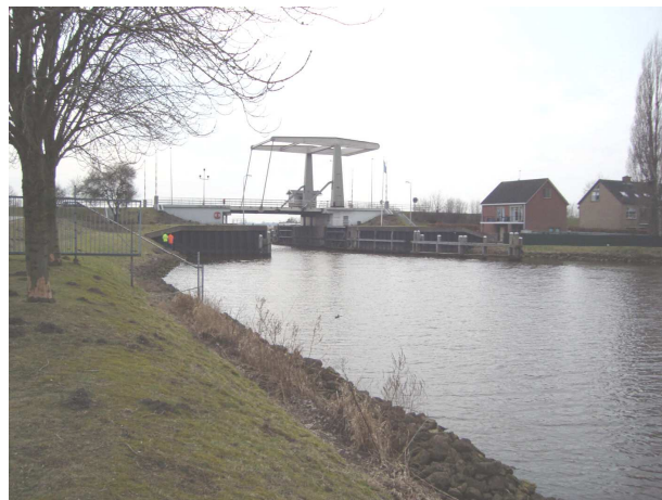
Foto 5: Keersluis vanuit het noorden gezien.
