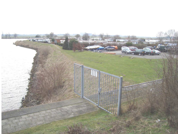
Foto 3: Camping ten zuidwesten van de keersluis.
