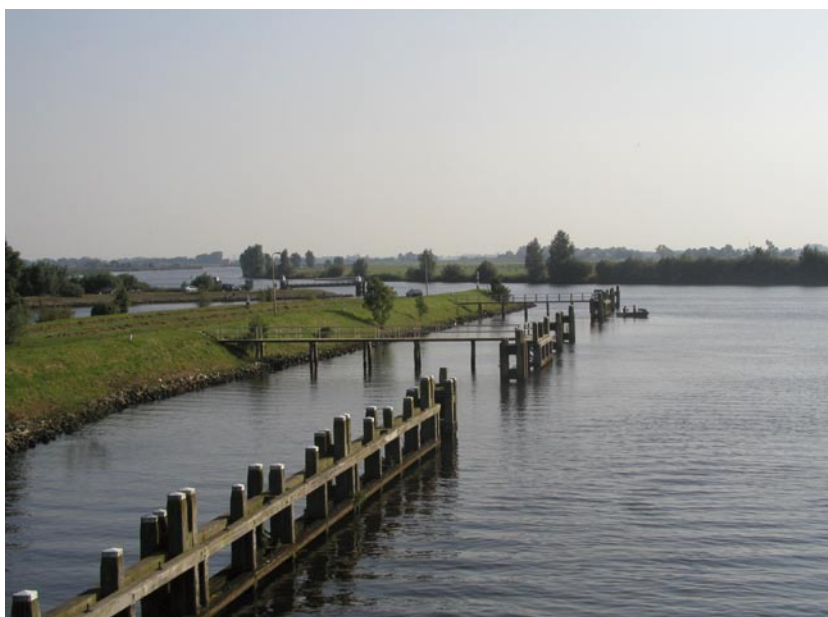
..... Figuur 3.3: Zicht op de aansluiting van het Meppelerdiep op het Zwarte Water
