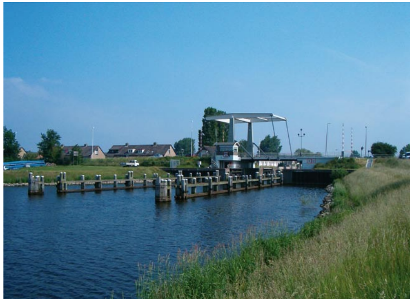
..... Figuur 2.5: Meppelerdiepkeersluis gezien vanaf Zwarte Waterzijde
