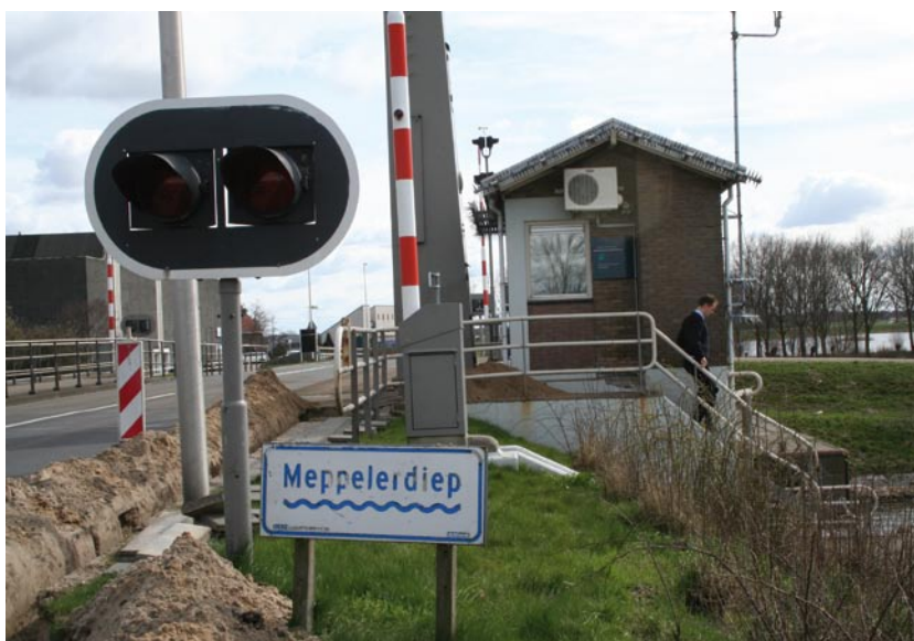
..... Figuur 2.8. Huidig bedieningsgebouw voor de Meppelerdiepsluis en -brug met links op de achtergrond gemaal Zedemuden.
