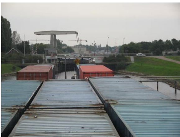
..... Figuur 1.1: Wachtende schepen aan beide zijden van de gesloten Meppelerdiepkeersluis
