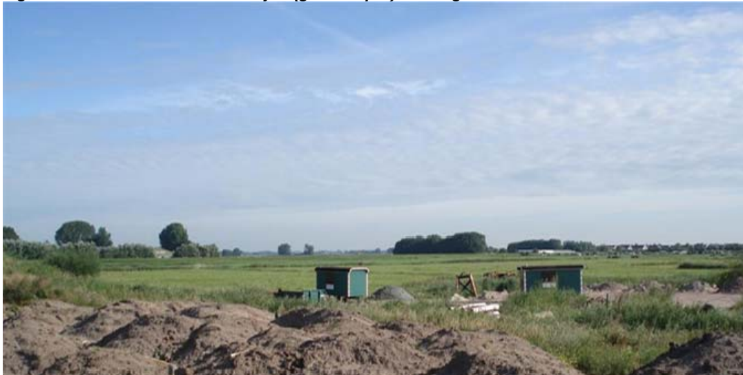
Figuur 1.3 Foto vanaf de zuidzijde (gronddepot) richting moestuinen in het noorden .
