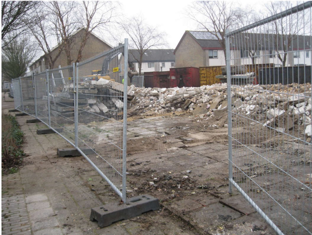
Overzicht terrein (woningen zijn reeds gesloopt)
