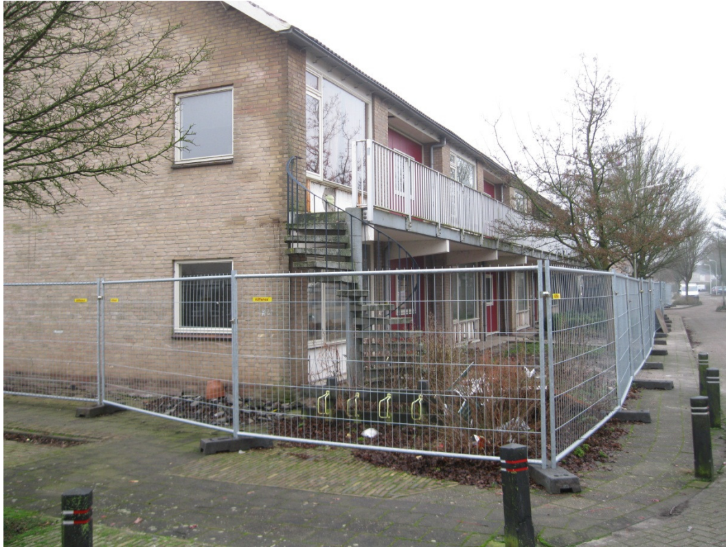
Overzicht vanuit zuidelijk deel van de onderzoekslocatie (voorafgaand aan sloop)
