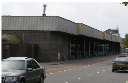
busstation vanaf het oosten (Stationsweg) huidige situatie
