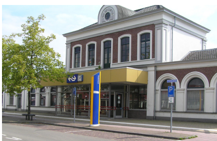
voorgevel stationsgebouw huidige situatie
