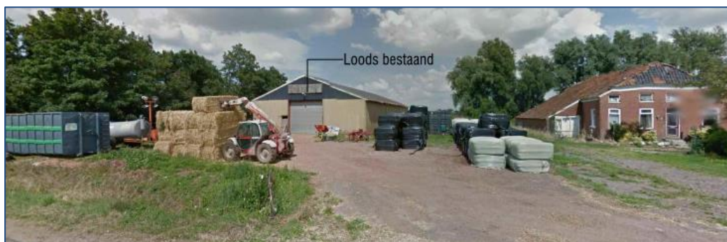
Figuur 1.1: Een weergave van het huidige perceel met zicht op de loods en voormalige boerderij.
