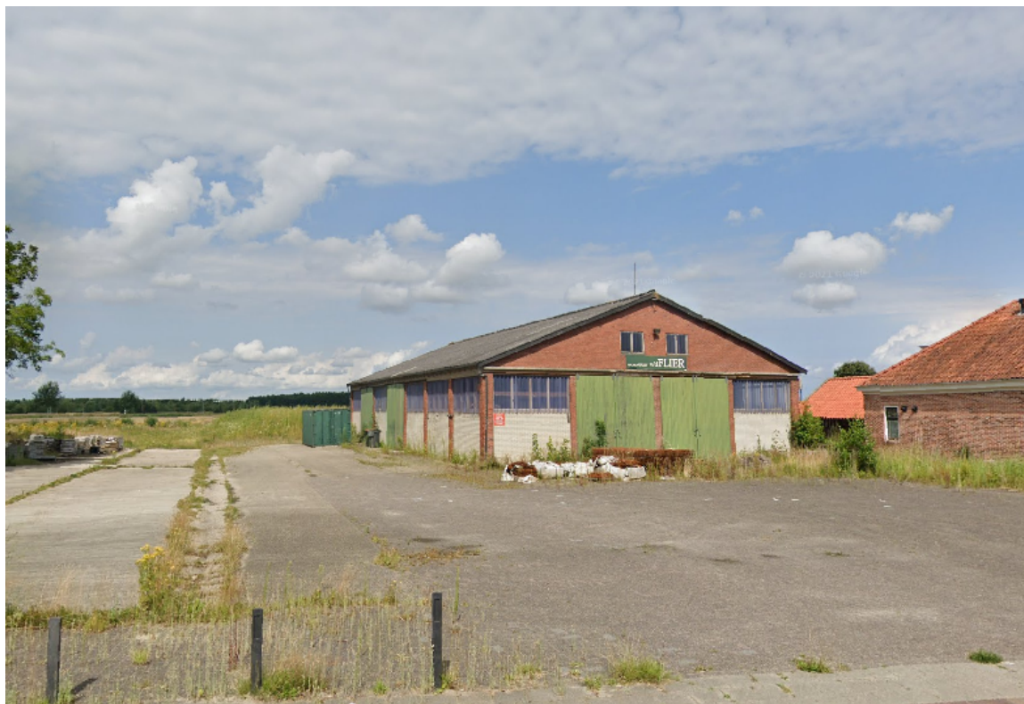
Figuur 6. bestaande bebouwing op het perceel (bron: Google Streetview).
